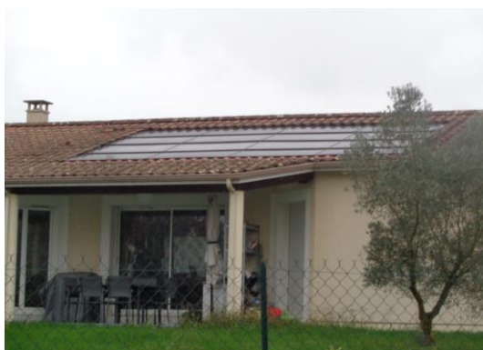
Dispositif solaire en toiture, vers Sérigeau (source : METROPOLIS)
