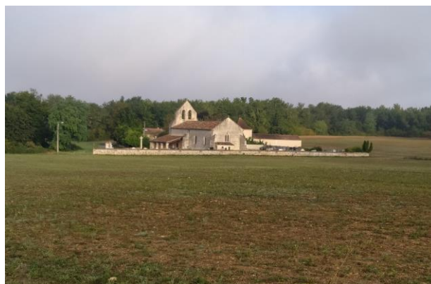
4. Vue sur l'Eglise Notre-Dame depuis Massé
