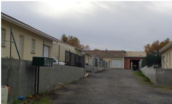
Vue sur les zones de développement récent sur la Borie de Castagny (source : METROPOLIS)
