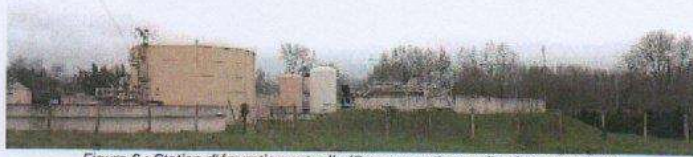
Figure 6 : Station d'épuration actuelle (Source : notice explicative, page 163)
