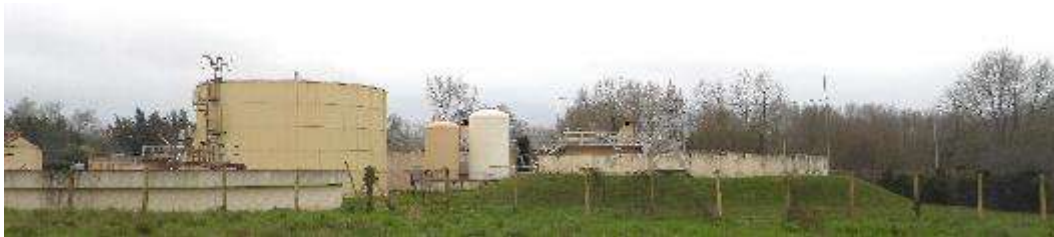
Figure 87: Station d'épuration actuelle (Vue 3)
