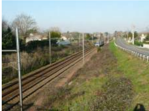
Voie ferrée en « décaissé » vers Sudre
