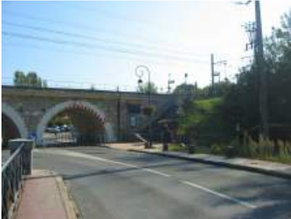
Voie ferrée en viaduc dans le bourg
