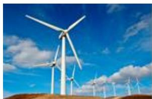
La puissance des éoliennes est très variable et peut permettre la production de quelques centaines de watt jusqu'à plusieurs mégawatt pour la plus puissante. Une éolienne commence à produire de l'électricité dès que le vent atteint une vitesse d'environ 4 mètres par seconde, mais pour atteindre une rentabilité économique, il faut une vitesse de 6 mètres par seconde.
