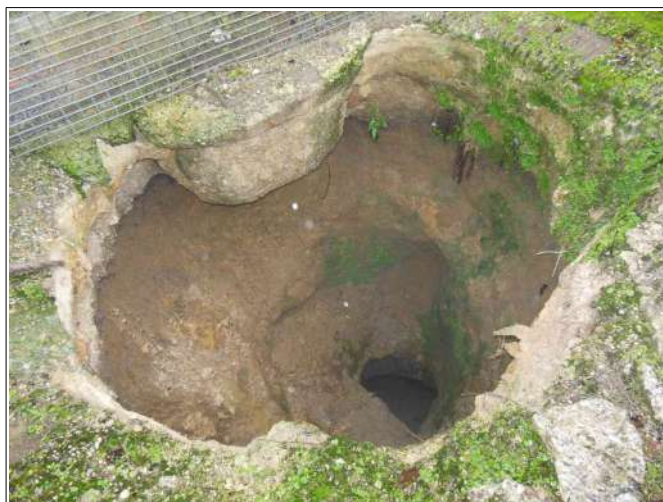
Fontis au droit d'un hangar de l'entreprise de maçonnerie Neveu (lieu-dit Garigau), on distingue au fond une ouverture en direction de la carrière sous-cavant ce secteur. On notera également la fondation suspendue du bâtiment (bloc de béton en haut de la photo).
