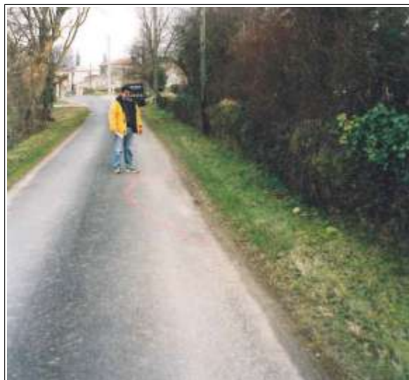
Affaissement de la voie communale n° 4 (marque rouge au sol). Cette voirie est aménagée au dessus d'une cavité déjà frappée par des mouvements de terrain souterrains.
